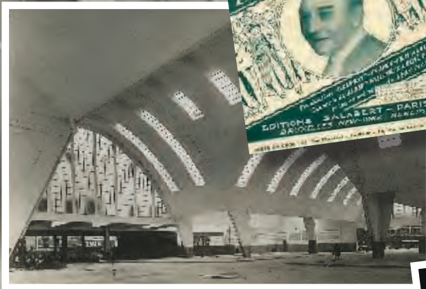
Construction de la salle des fêtes des Grésillons, 1930.
